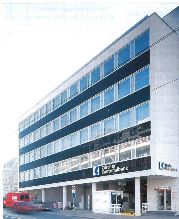
1 Sanierte Gebäudefront «Schaffhauserstrasse».
