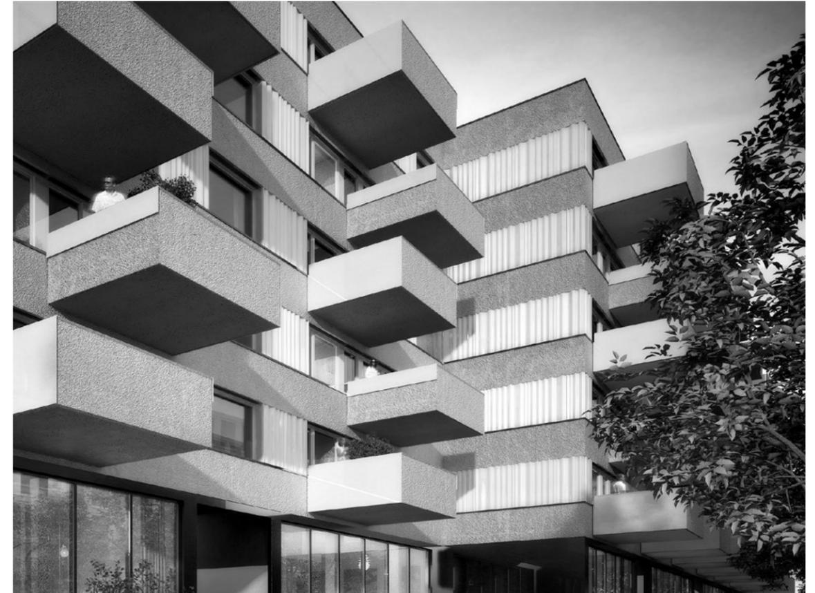
Mit dem Einsatz einer spezifisch für das Projekt hergestellten perlmuttartigen Kunststoff-Lichtwellplatte wird den Fensterbändern eine eigene Wertigkeit verliehen. Die Materialisierung harmoniert mit den geforderten Kunststoff-Fenstern und erinnert im Ausdruck an einen vom Wind gewellten Vorhang.
