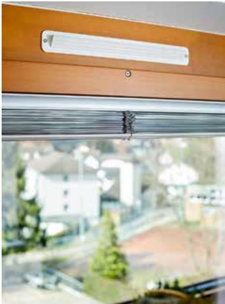
Der Aussenluftdurchlass (weisse Lamelle) ermöglicht das Lowtech-Lüftungskonzept.
