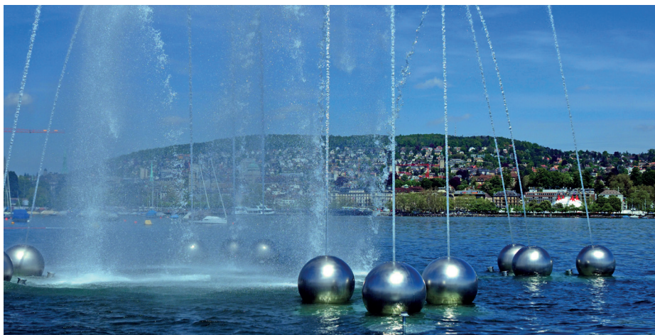
Die Kugeldüsen aus 8 Millimeter starkem Edelstahl sind die beständig sichtbaren Elemente. Sie dienen mit 120 Zentimeter Durchmesser als Schwimmkörper für die ca. 30 Tonnen schwere Gesamtstruktur. Foto: David Fuchs / Metallatelier GmbH
