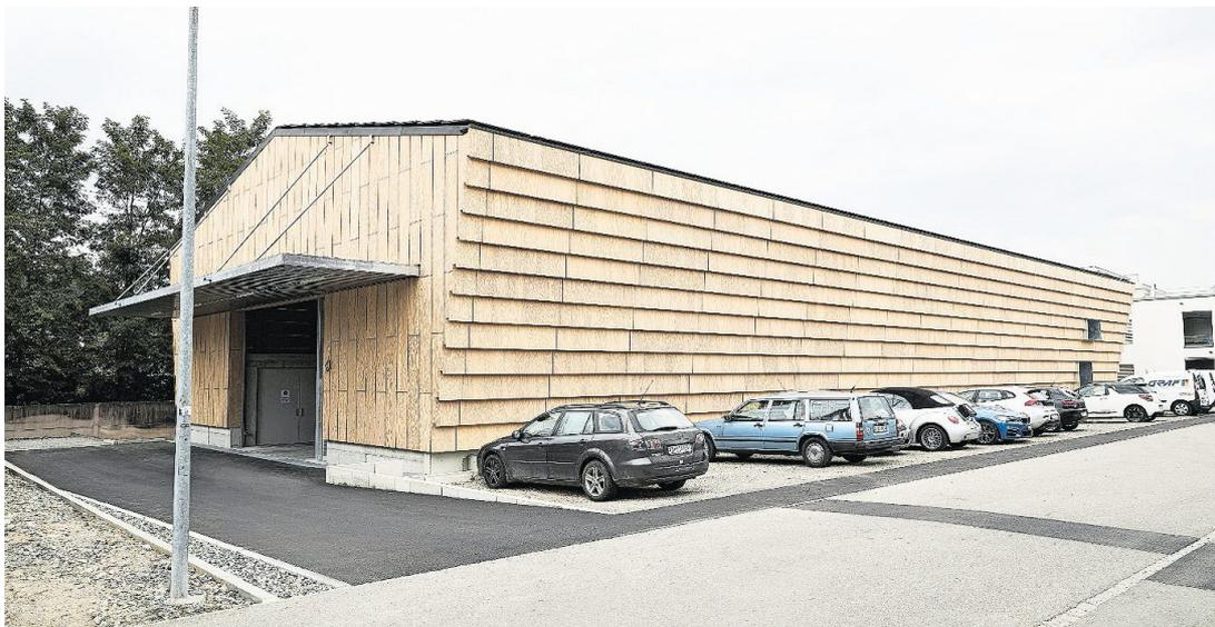
Entstanden ist eine Holzkonstruktion in Leichtbauweise.
