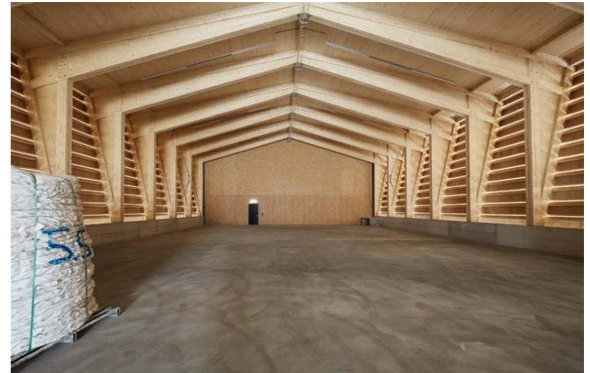
Die Materialisierung beschränkt sich im Wesentlichen auf drei Materialien – Beton, Holz und verzinkte Metallteile –, die alle samt roh belassen werden und dadurch dem Äusseren des Gebäudes über den natürlichen Alterungsprozess seine Patina verleihen. Der Ausdruck als Folge der Konstruktion sucht ein archaisches Bild einer Scheune und überzeichnet dieses. Darin findet die Lagerhalle ihre eigene Kraft und wird zum identitätsstiftenden Anker für den neu ausgebildeten Werkhof.
