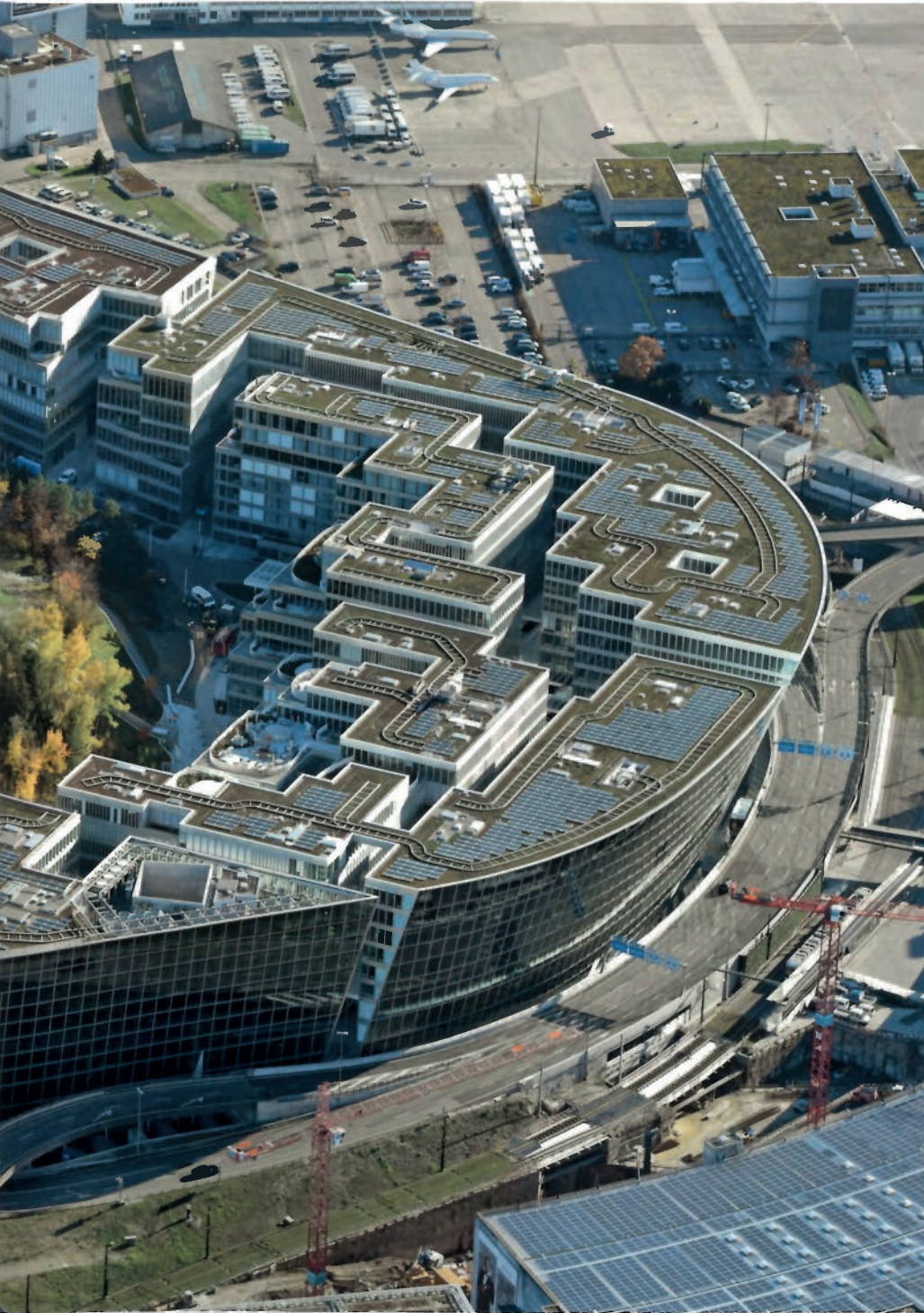
Die gläserne «Banane» des Circle trennt den Erholungsraum des Butzenbüels von der Verkehrsdrehscheibe. Bild: Simon Vogt / Flughafen Zürich
