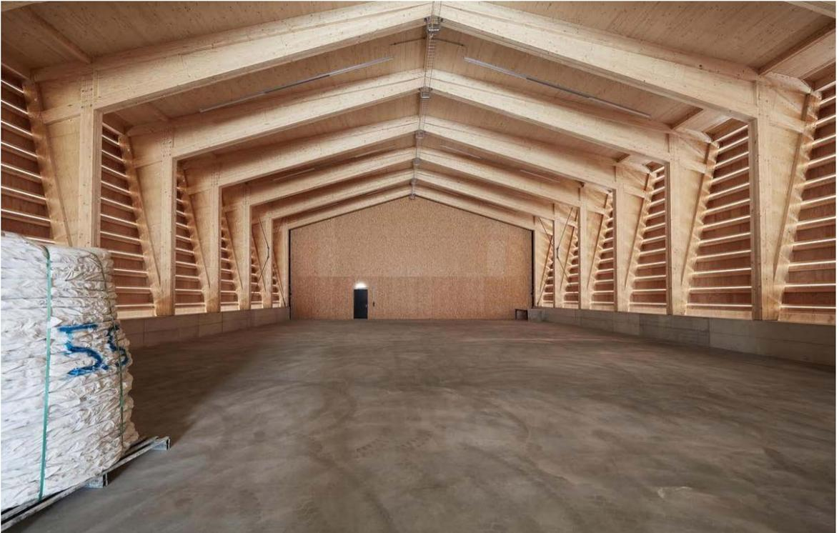
Die Halle ist über die gesamte Länge von 45 Metern stützenfrei.
