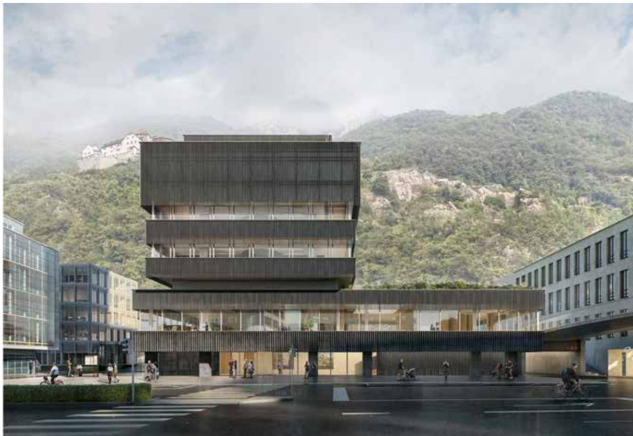
Morger Partner Architekten aus Basel haben die Brüstungsbänder und das dritte Obergeschoss des Siegerprojekts «896795» mit vertikalen Holzlamellen verkleidet.
