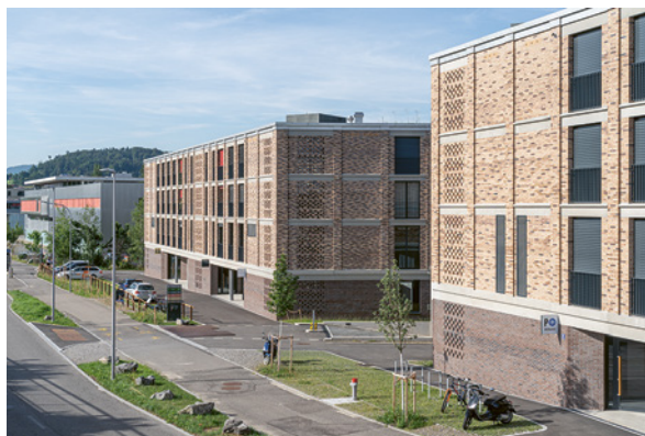
Die exponierte Strassenfassade
