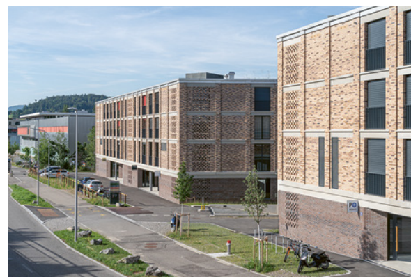
Die exponierte Strassenfassade
