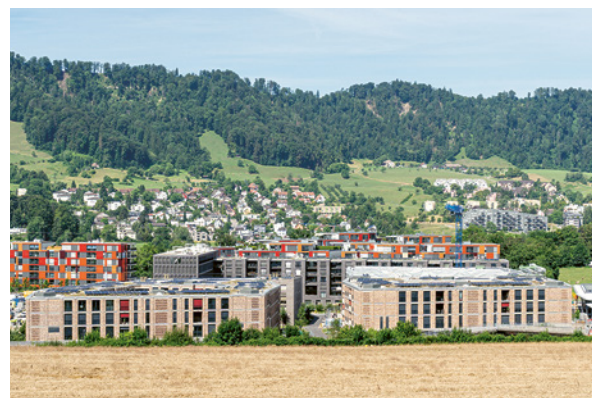
Blick über die Autobahn auf das teilweise fertiggestellte Quartier
